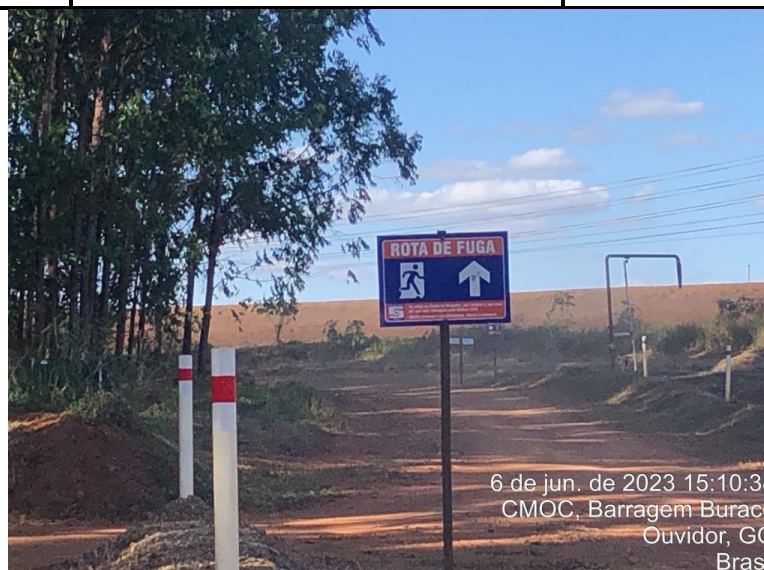
Figura 13.3 – Detalhe para sinalização de Rota de Fuga e orientações.
