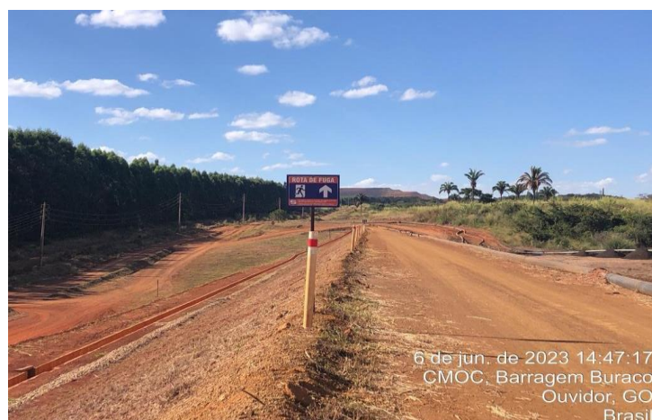
Figura 13.2 – Sinalização de Rota de Fuga e Orientações.
